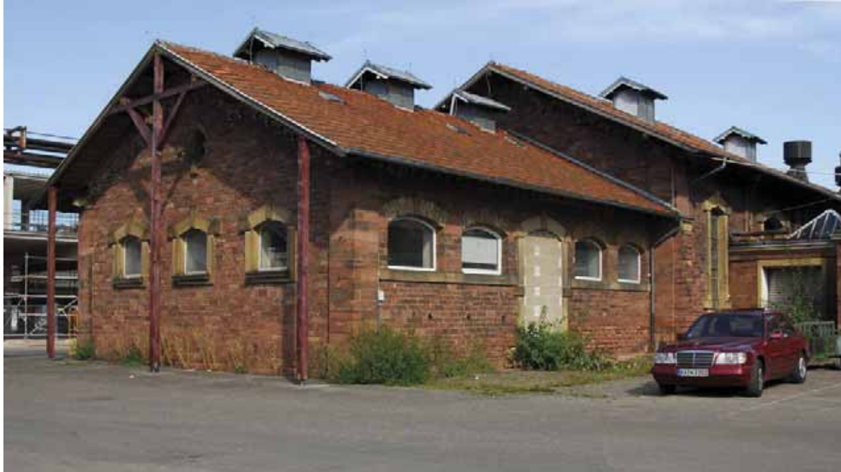
Stallgebäude Alter Schlachthof
